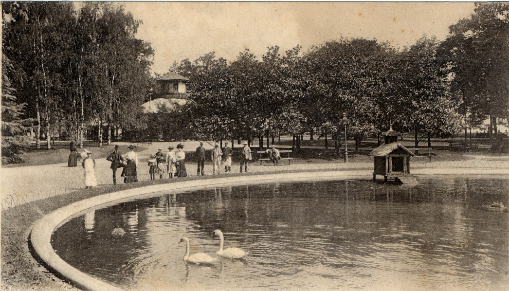
69 MOULINS. — La Place de la République. — La Pièce d'Eau. — LL.
